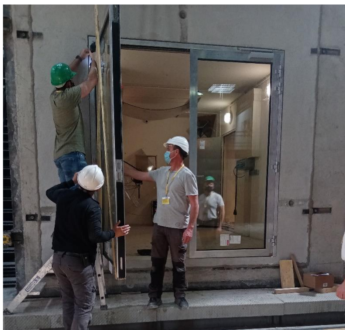
Mise en place des vantaux
