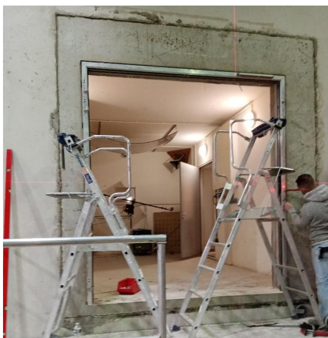
Mise en place de l'huissérie
