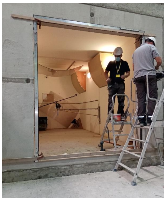
Mise en place de l'huissérie
