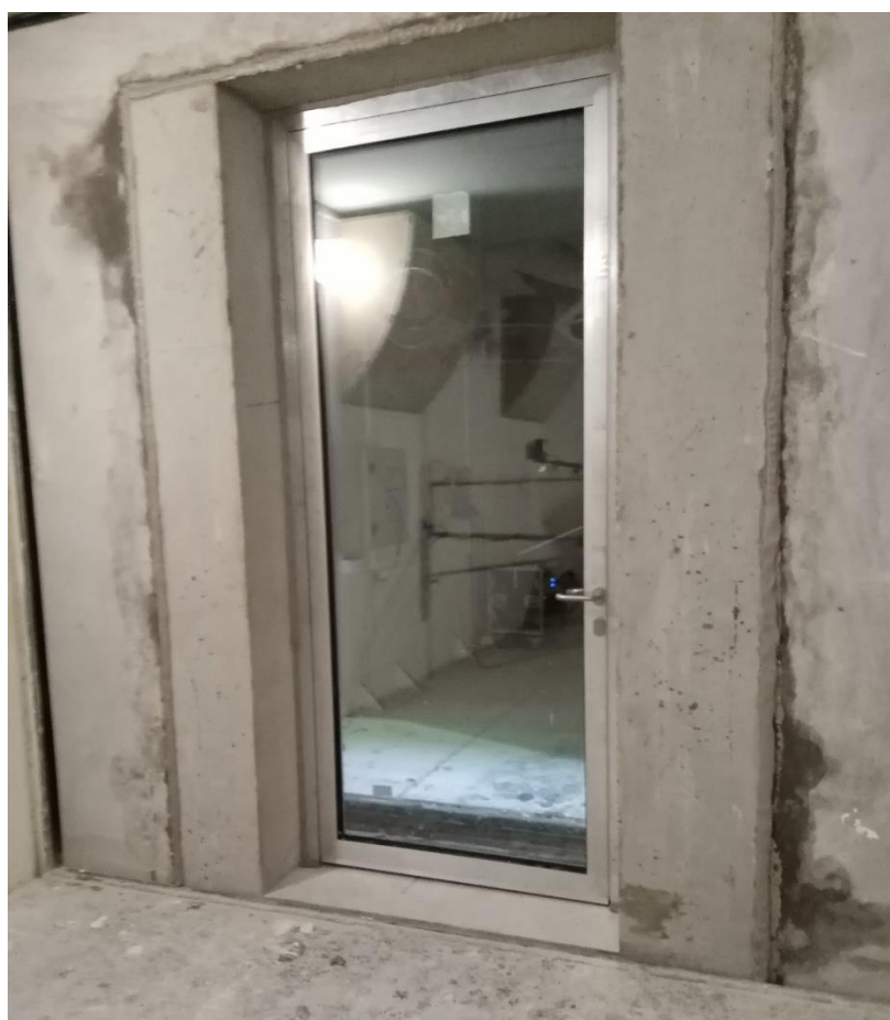
Bloc porte vu côté réception
