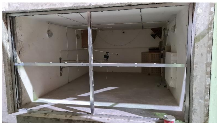
Mise en place de la cloison
