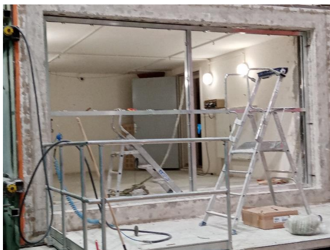
Mise en place de la cloison
