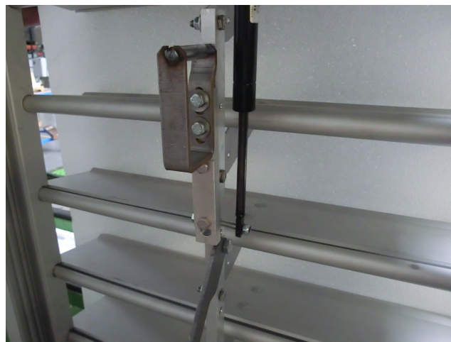
AIRLAM V2 en position de sécurité (ouvert), démonter le levier de réarmement manuel et le système « gâche ».
