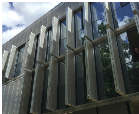
DIGITEO LABS - Palaiseau / © BRS Architectes
