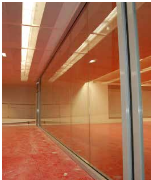
"Plaine Oxygène" - Le Mesnil-Amelot (77) Cloisons vitrées bord à bord EI 60 © Minram
