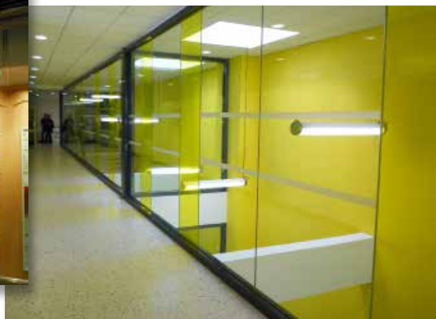
ISAE - Toulouse (31) Cloisons vitrées bord à bord coupe-feu 1/2 h © Atelier 13
