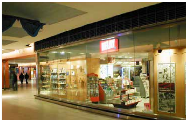
Gare du Nord - Paris (75) Cloisons vitrées bord à bord coupe-feu 1h © D.A
